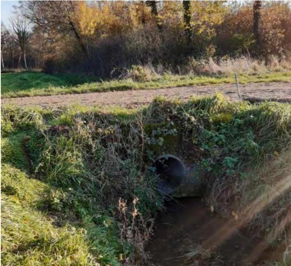
Figure 57 : Exemple de buse pouvant être mise en place
