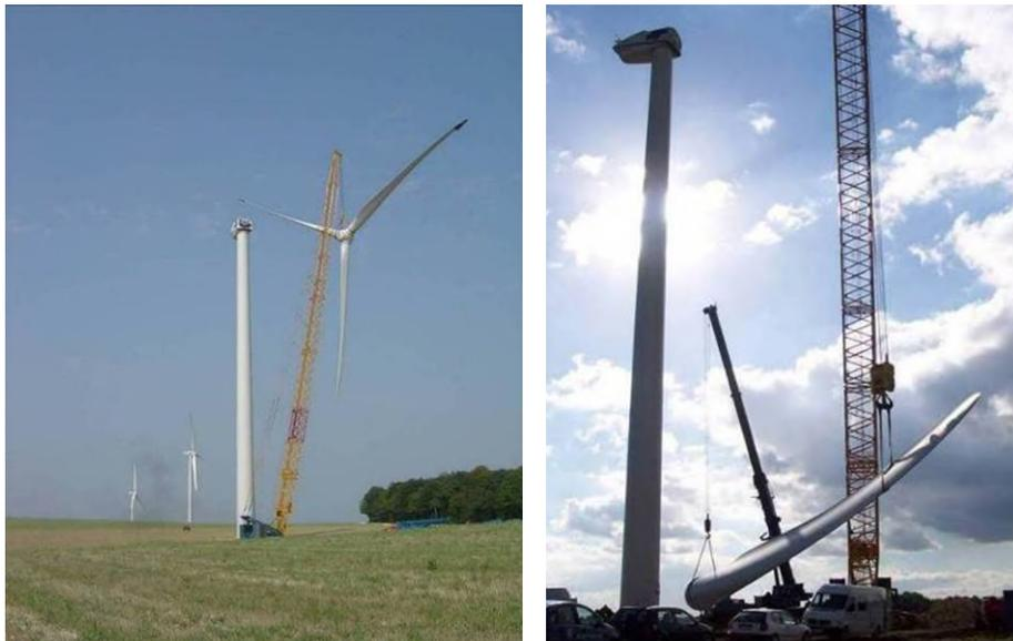
Figure 25 : Grue de montage et élevage du rotor
