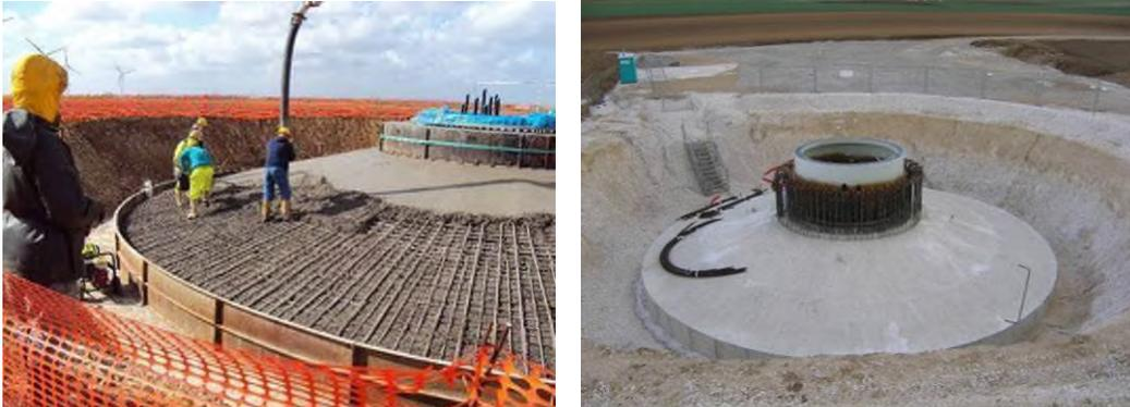
Figure 24 : Fondation type avec le système de fixation du mât
