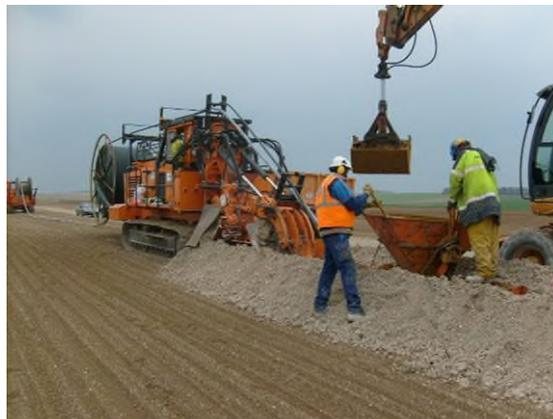
Figure 27 : Tranchée pour l'enfouissement des câbles électriques
